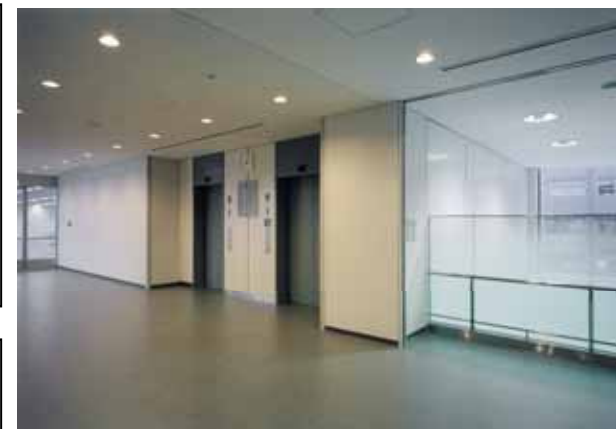
増築庁舎のエレベーター (右)貨物用 B1～6F (左)一般用 1F～6F
