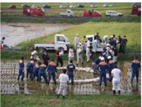
群馬県明和町漏水状況(H19)
