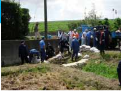
千葉県香取市漏水状況(H19)
