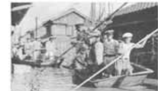
昭和22年洪水による被災地域の状況(埼玉県)
