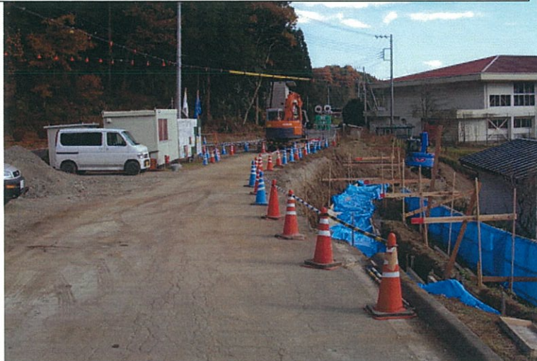
工事用道路工事(現道の拡幅)
