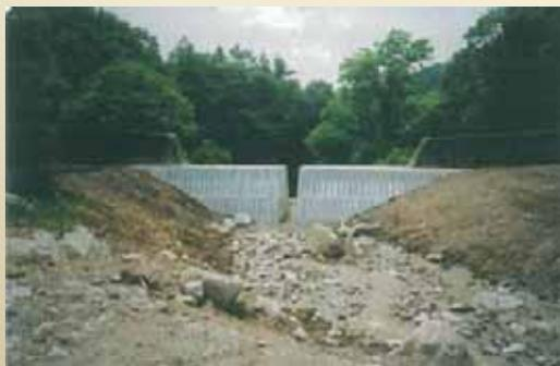
通常時は流水・土砂の流れの連続性を保ち、出水時は有害土砂を捕捉するなど、総合的な土砂の管理を図ります。
