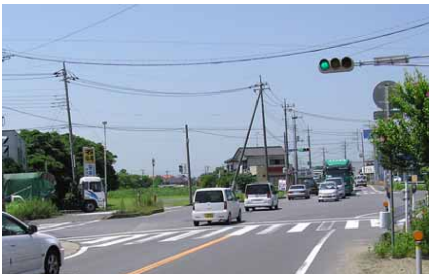
写真 おおふなつ 大船津交差点の交通状況（供用後） B 方向から （平成 17 年 7 月撮影）
