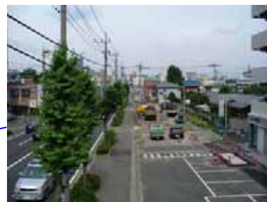
470m区間工事状況
