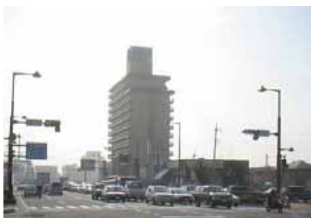
群馬大橋方面への状況
