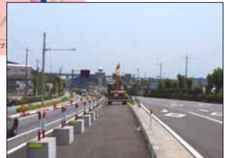
写真 拡幅前の様子 (H17 夏供用予定区間)
