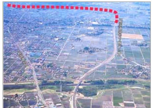
写真：下館バイパス（終点側から起点方向を望む）
