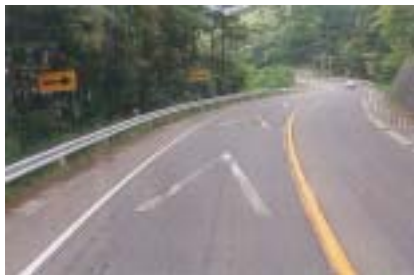
写真 A 線形不良箇所
