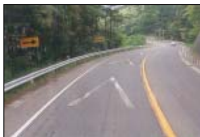
写真B 線形不良状況
