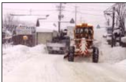
写真A 除雪状況
