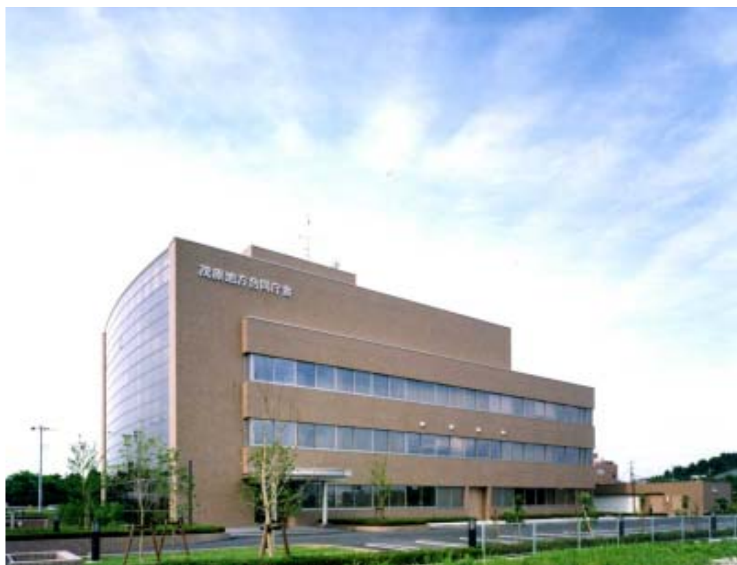
茂原地方合同庁舎
