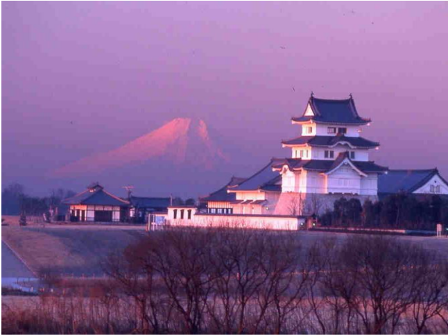
利根川境河岸付近堤防
