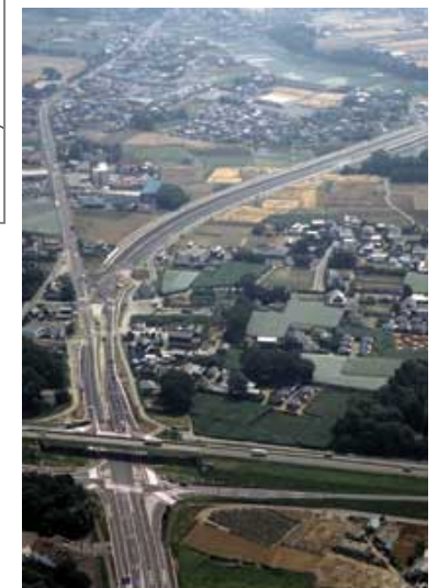
結城バイパス(茨城県結城市)
