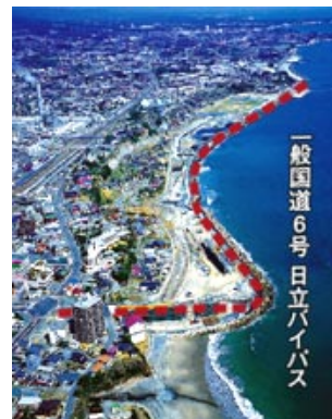
日立バイパス (旭高架橋から終点方向を望む)
