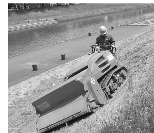
堤防を機械で除草している様子
