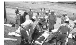
漏水対策である「月の輪」工法を実施
