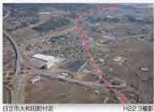
日立市大和田町付近
