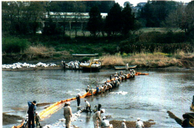
濁水時における防潮フェンス設置の作業状況
