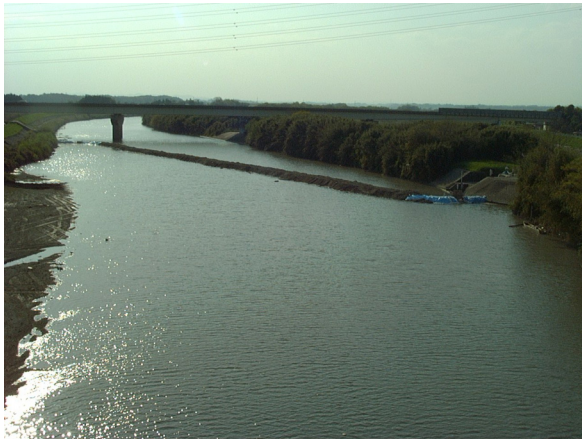
仮締切堤設置
