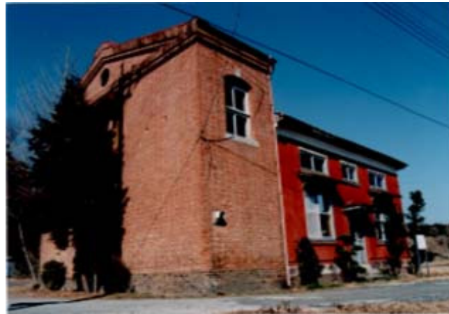
旧町屋変電所（常陸太田市）
