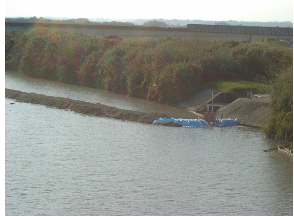
仮締切堤設置
