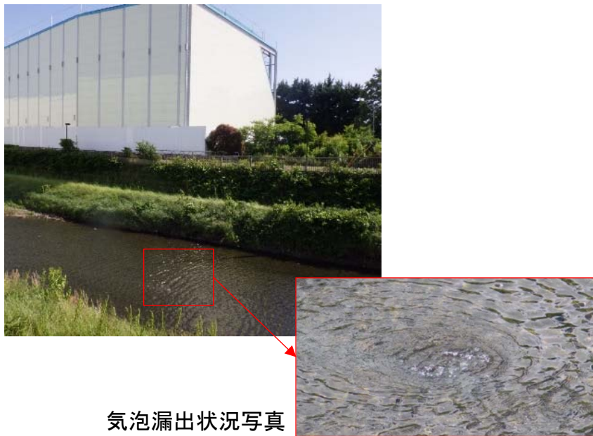
東名JCT周辺の野川の漏気状況
