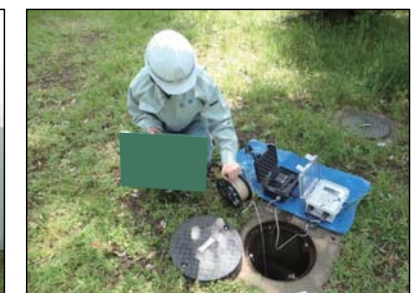
地下水位の観測状況
