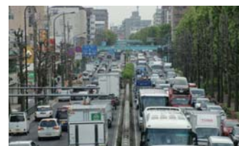
環状8号線(世田谷区八幡山2丁目付近)
