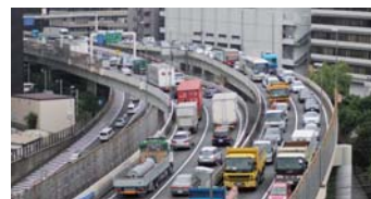
首都高速都心環状線(神田橋JCT)の状況
