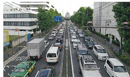
環状8号線 (杉並区高井戸東2丁目付近)
