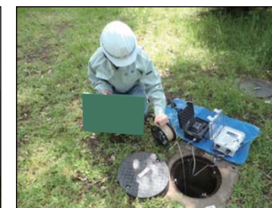
地下水位の観測状況
