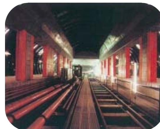
施工中の三連駅シールド(白金台駅)
