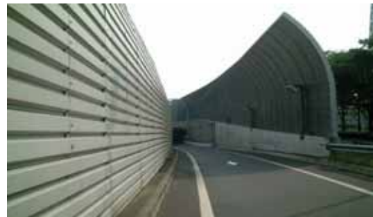
遮音壁（外環 和光地区）
