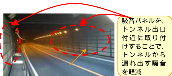
トンネル内の吸音処理
