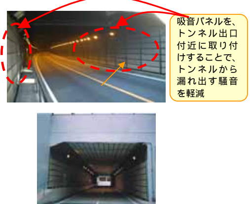
トンネル内の吸音処理
