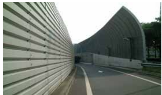
遮音壁（外環 和光地区）
