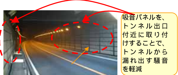
トンネル内の吸音処理
