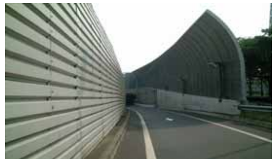
遮音壁（外環 和光地区）
