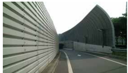
遮音壁（外環 和光地区）
