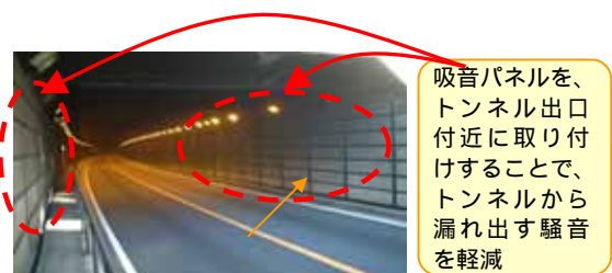
トンネル内の吸音処理
