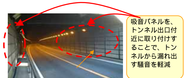
トンネル内の吸音処理
