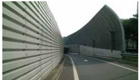
遮音壁（外環 和光地区）
