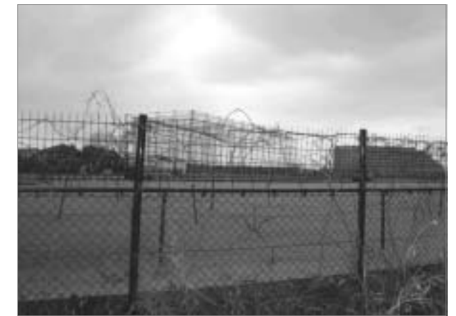
もみじ山より練馬外環(外環本線上部)
