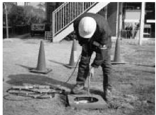
地下水位計設置（キタクリーンファーム）
