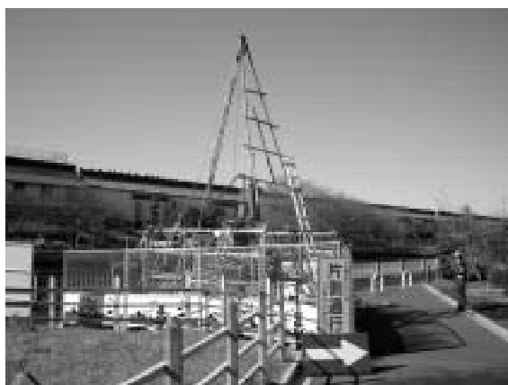
地質調査(世田谷区区道)
