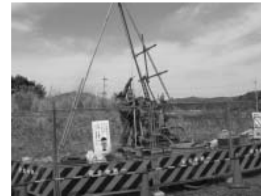
< ボーリング調査方法 >
