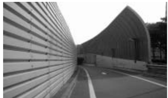
遮音壁（外環 和光地区）
