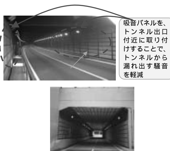
トンネル内の吸音処理
