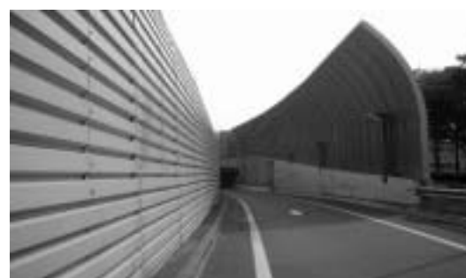
遮音壁（外環 和光地区）
