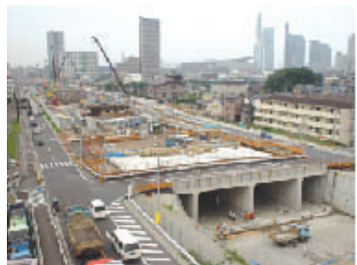
開削工事事例（首都高/埼玉新都心線）
