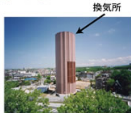
名古屋高速道路東山トンネル 東山換気所
