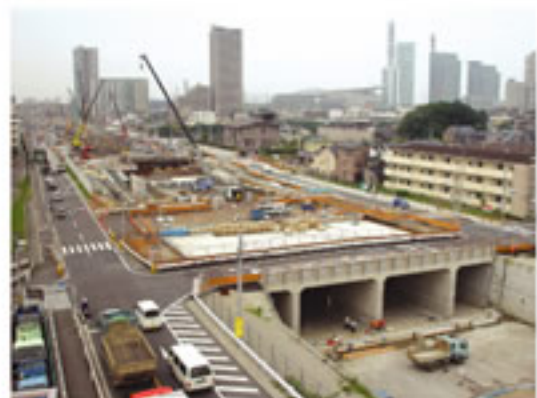
開削工事事例(首都高/埼玉新都心線)
