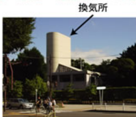
国道20号新宿御苑トンネル 新宿御苑換気所
