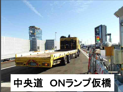
中央道 ONランプ仮橋
