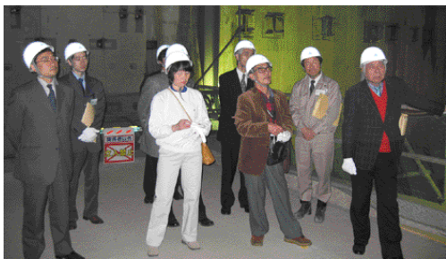
沿線協議会は現地視察を2回行った（写真は平成15年4月、新宿・首都高速の工事現場）
