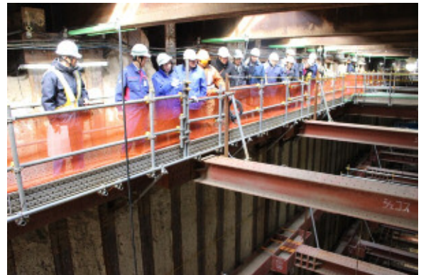
工事状況の視察(開削部)
