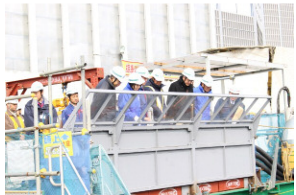
工事状況の視察(立坑上部)
