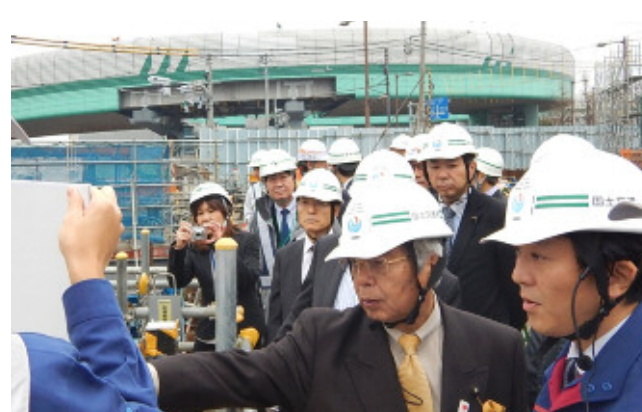
白子川改良工事視察状況
