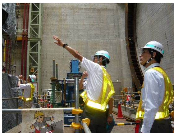
説明状況(立坑・東名JCT)
