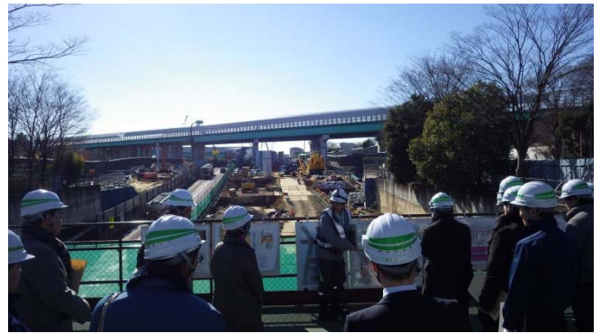
説明状況(大泉立坑)
