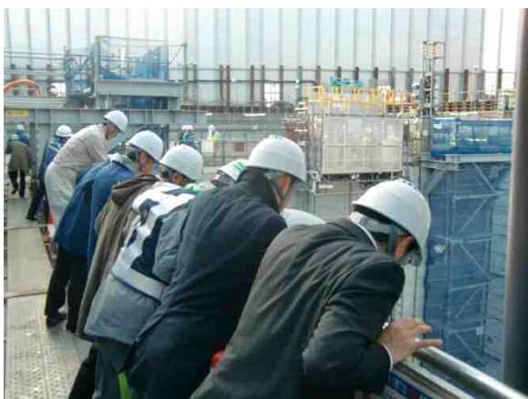
説明状況(立坑)
