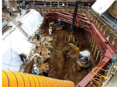
①地上からの開削作業
