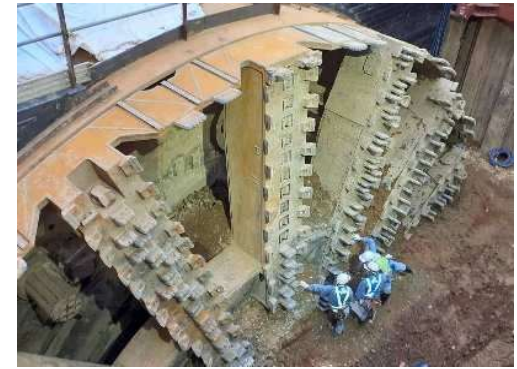
②損傷した部材等の確認
