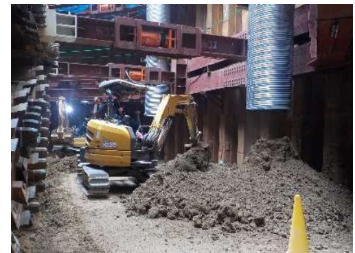
④開削範囲の埋め戻し
