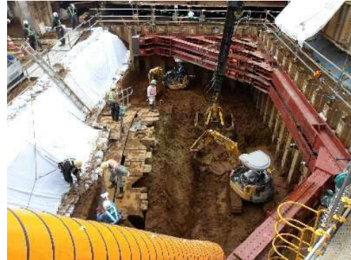
①地上からの開削作業
