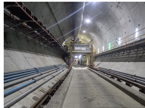
Hランプ坑内(シールド先端部)
