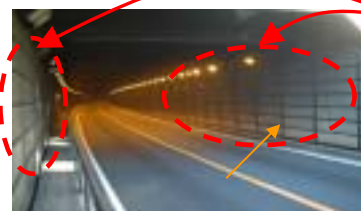
トンネル内の吸音処理
