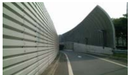
遮音壁（外環 和光地区）
