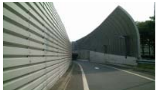
遮音壁（外環 和光地区）
