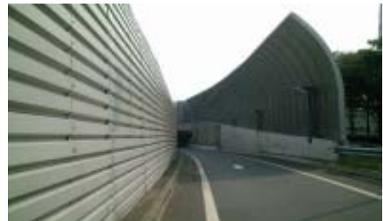
遮音壁（外環 和光地区）
