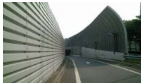
遮音壁（外環 和光地区）
